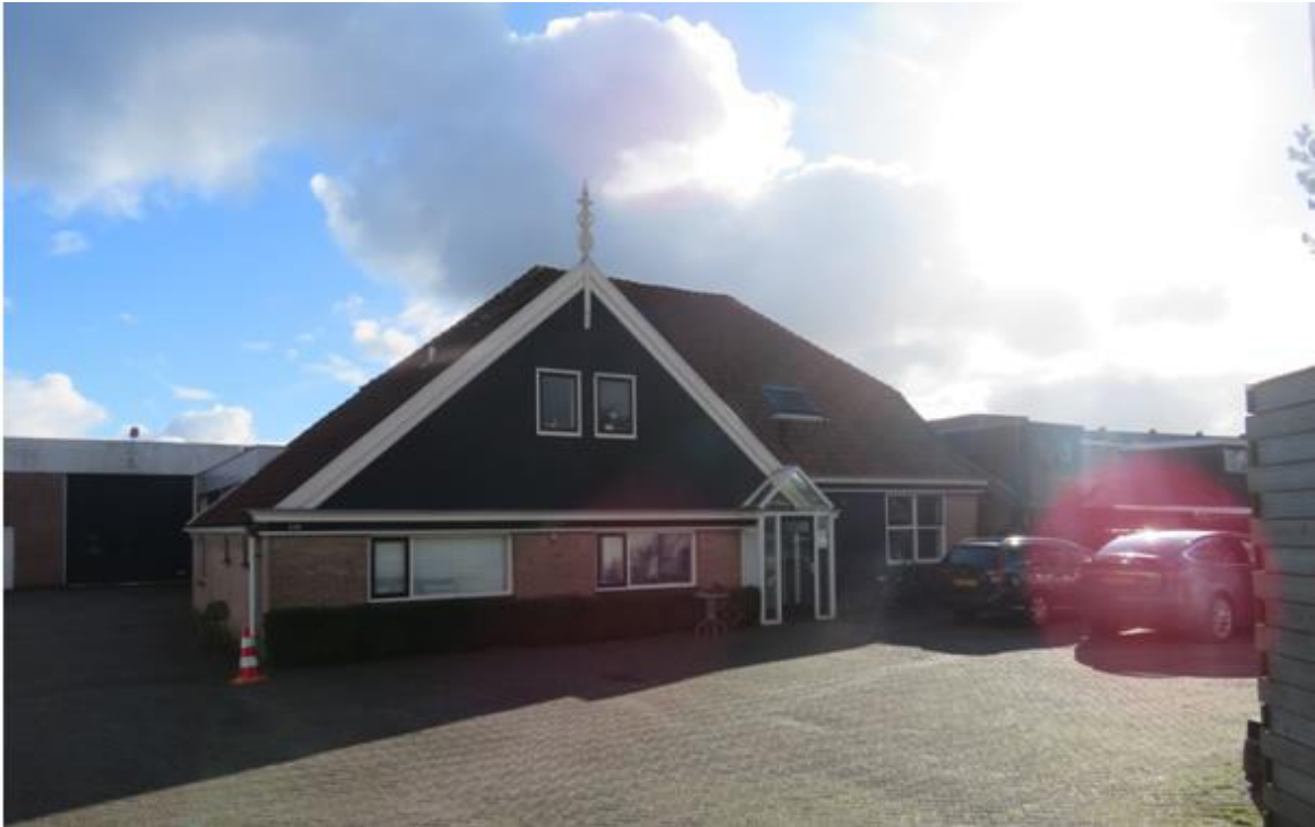
Figuur 3.2 Kantoorpand Kennemerstraatweg 215, Alkmaar
