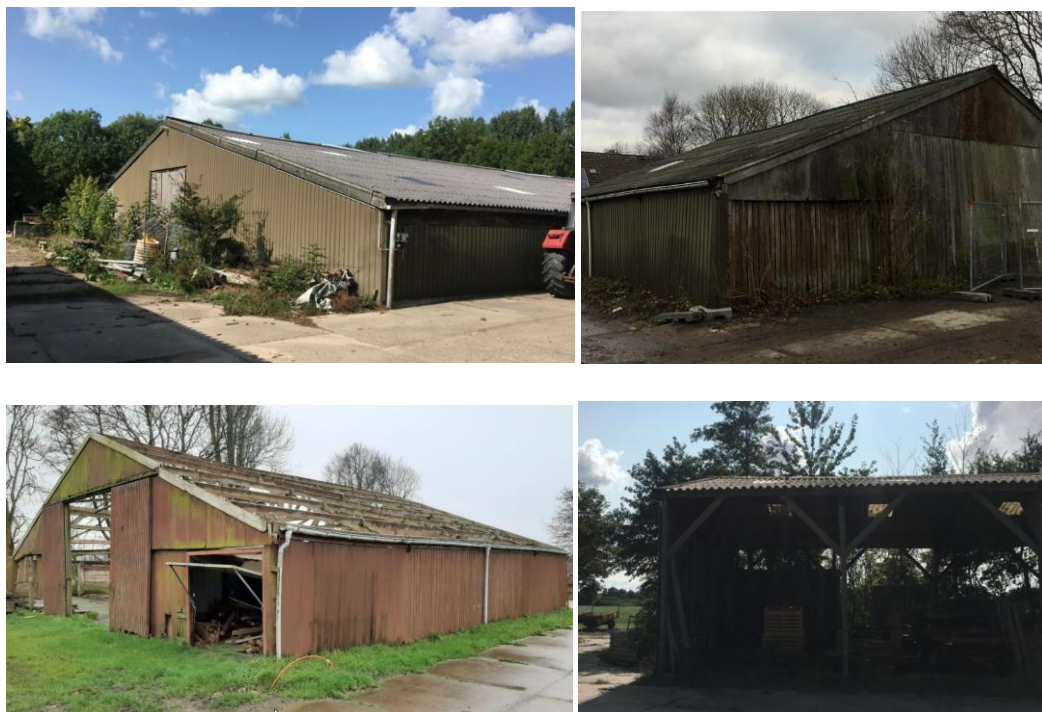
Figuur 7: Foto's voormalige bedrijfsgebouwen op het erf Nauertogt 21 A
