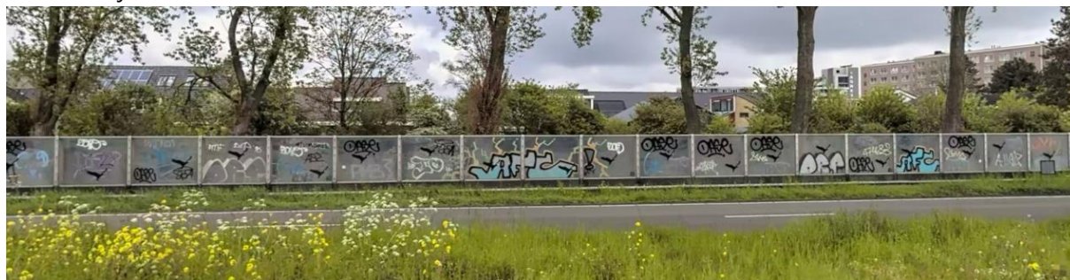
Zicht op het bestaande scherm langs de N9 Alkmaar
