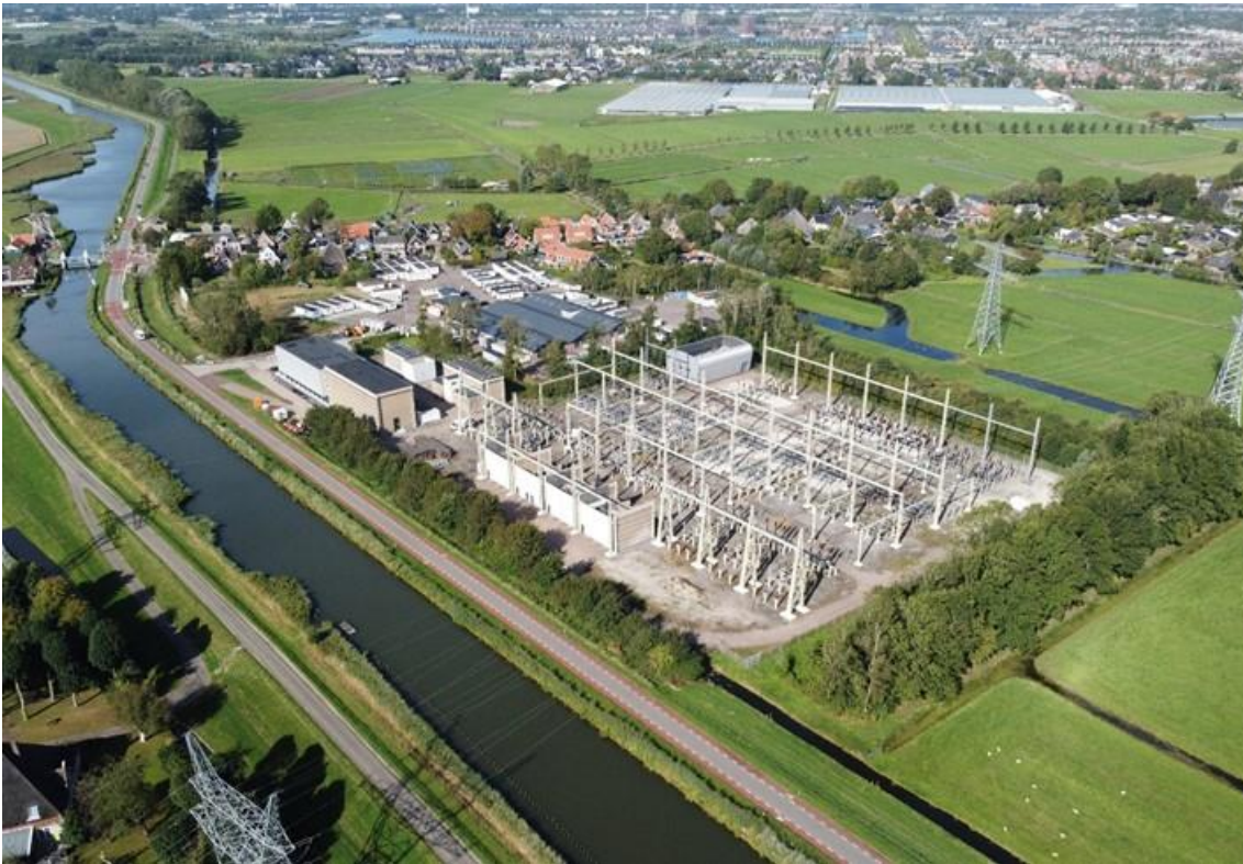
afbeelding 4: luchtfoto transformatorstation Oterleek (bron: HoogspanningsNet Netkaart)
